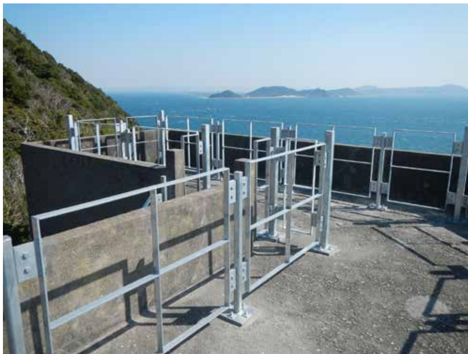
施工完了。屋上には転落防止用のさくが設けられました。
