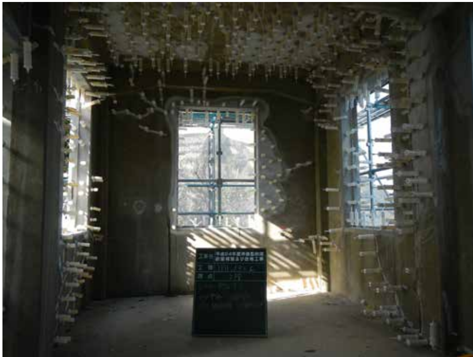
エポキシ樹脂注入状況。注入箇所は、ひび割れ箇所：6箇所 / m、剥離・剥落（断面修復）箇所：25箇所 / m 2 （写真は内部壁・天井）。
