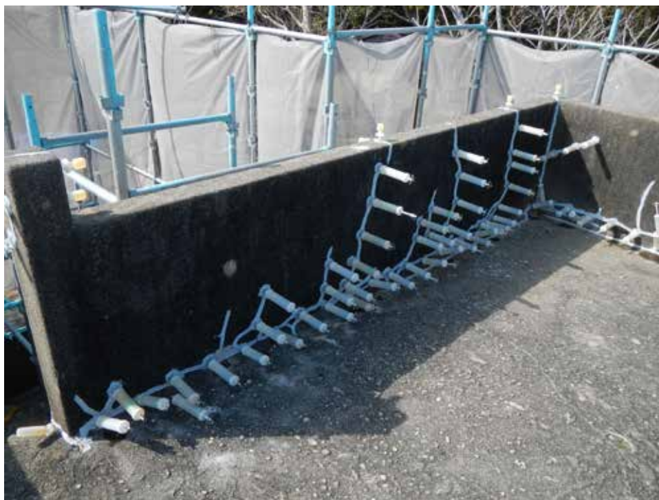
エポキシ樹脂注入状況。注入箇所は、ひび割れ箇所：6箇所 / m、剥離・剥落（断面修復）箇所：25箇所 / m 2 （写真は外部屋上）。
