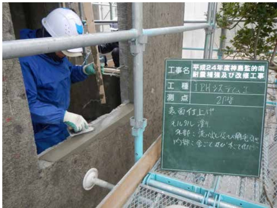
建具開口廻り表面仕上げ状況（モルタル塗り）。
