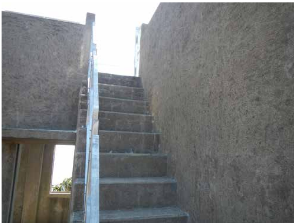
施工完了。外部階段には、昇降用の手摺が設けられました。
