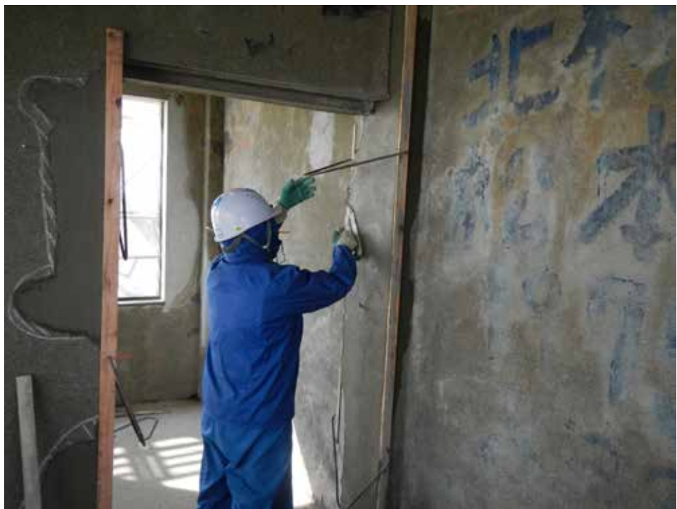
柱の表面仕上げ状況（モルタル塗り）
