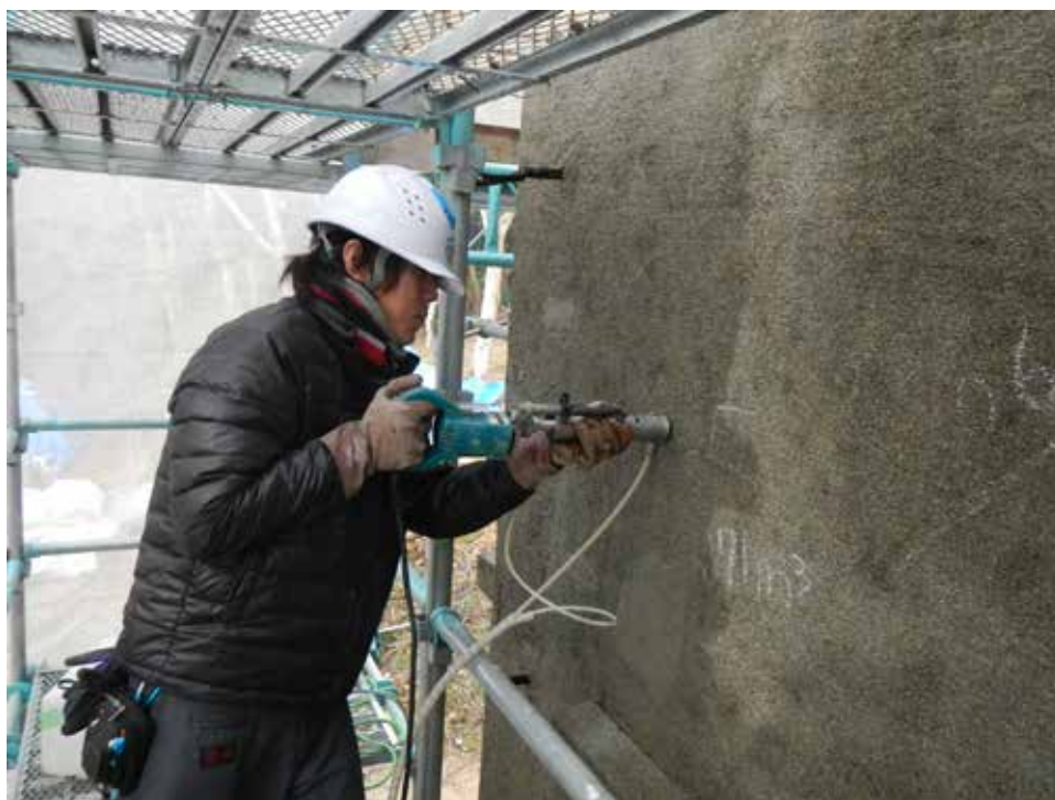
樹脂注入箇所を穿孔します（外壁ひび割れ・剥落箇所）。穿孔径はφ 7.0 mm、深さはかぶり厚～ 40 mm程度。粉塵は湿式の循環システムで回収しますので、ほぼ無塵で穿孔できます（I PHシステム工法）。
