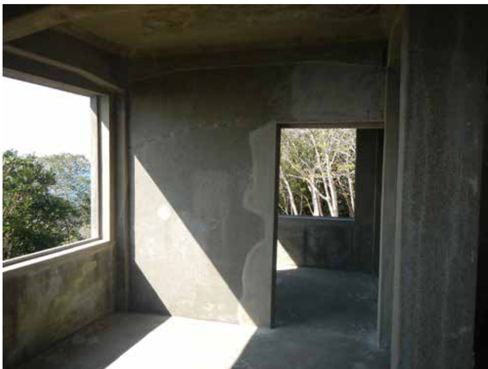
施工完了。2 階内部。
