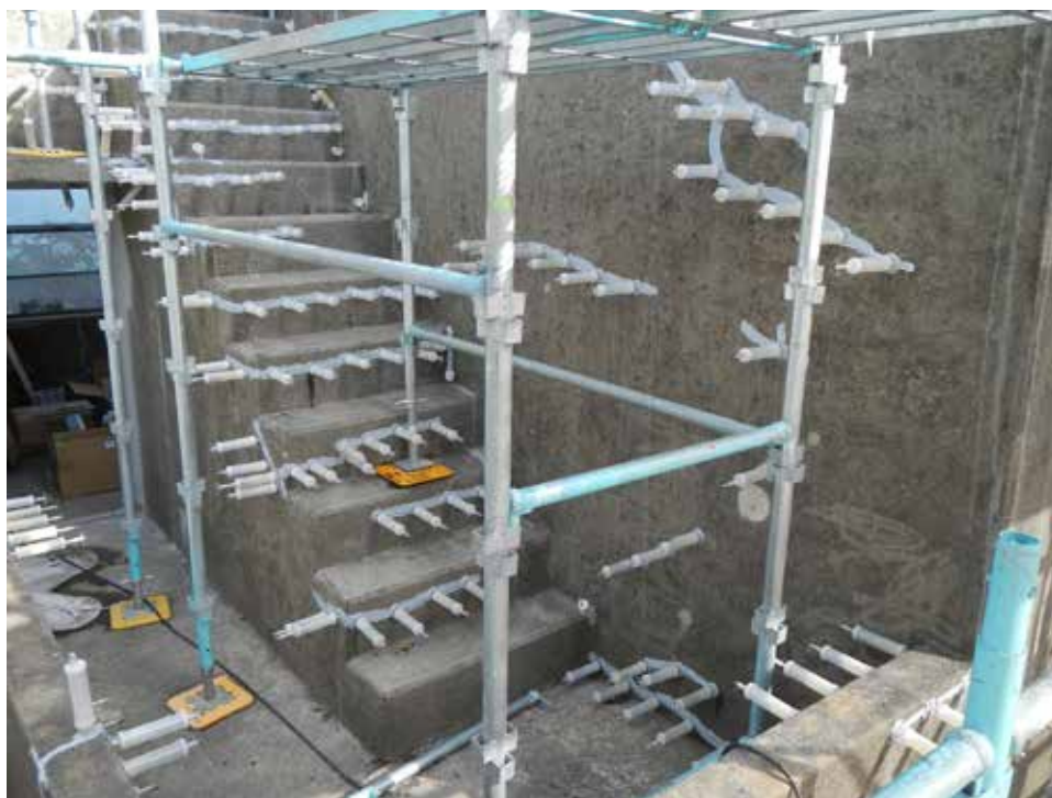
エポキシ樹脂注入状況。注入箇所は、ひび割れ箇所：6箇所 / m、剥離・剥落（断面修復）箇所：25箇所 / m 2 （写真は外部階段）。
