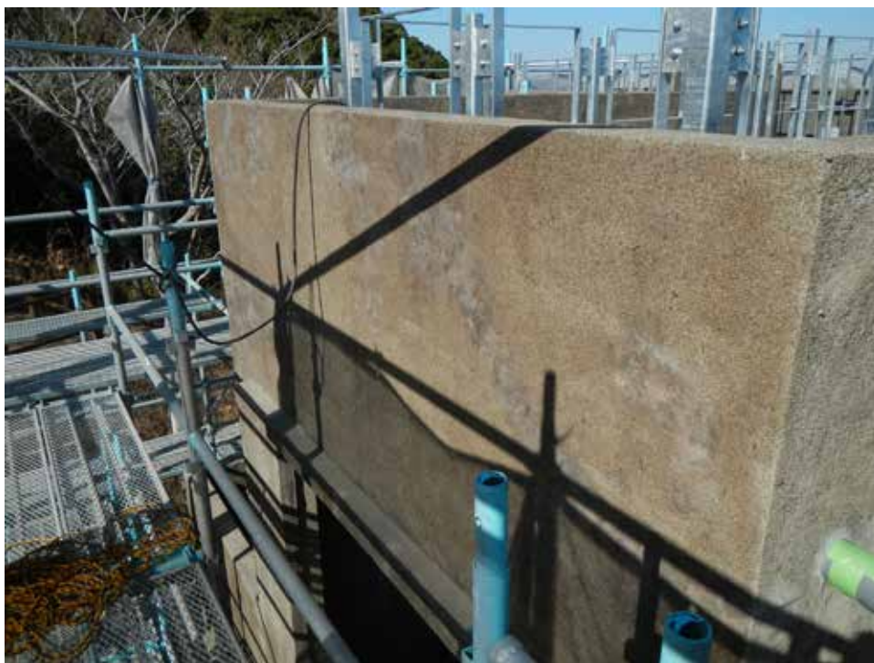
外壁の仕上げ状況。監的哨のひなびた雰囲気を保つため、左官補修材を調色して塗布しました。
