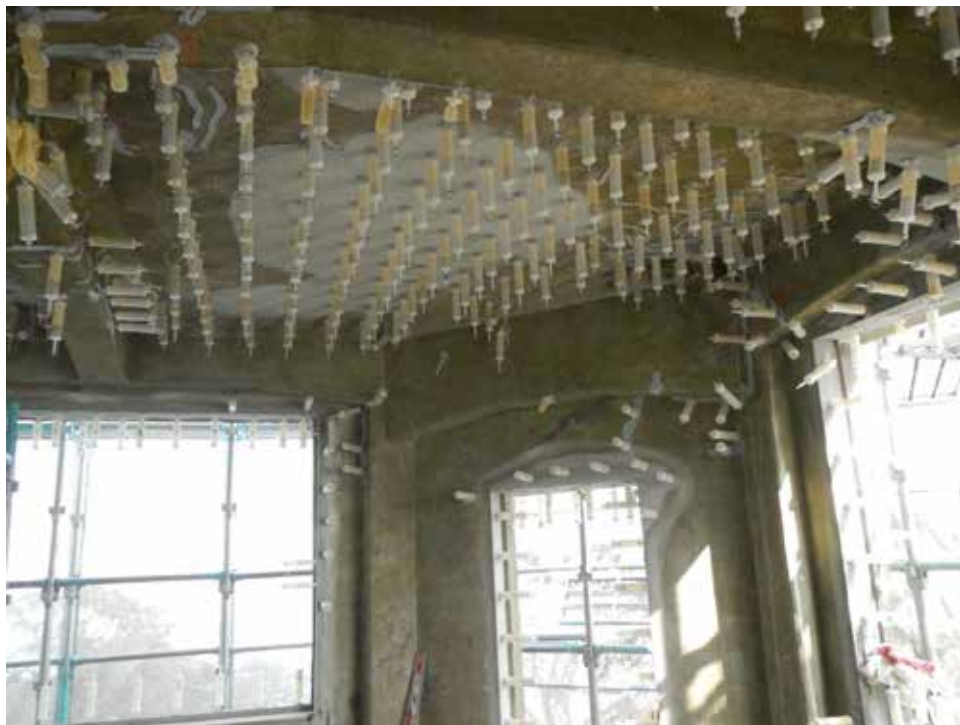
エポキシ樹脂注入状況。注入箇所は、ひび割れ箇所：6箇所 / m、剥離・剥落（断面修復）箇所：25箇所 / m 2 （写真は内部梁・天井）。
