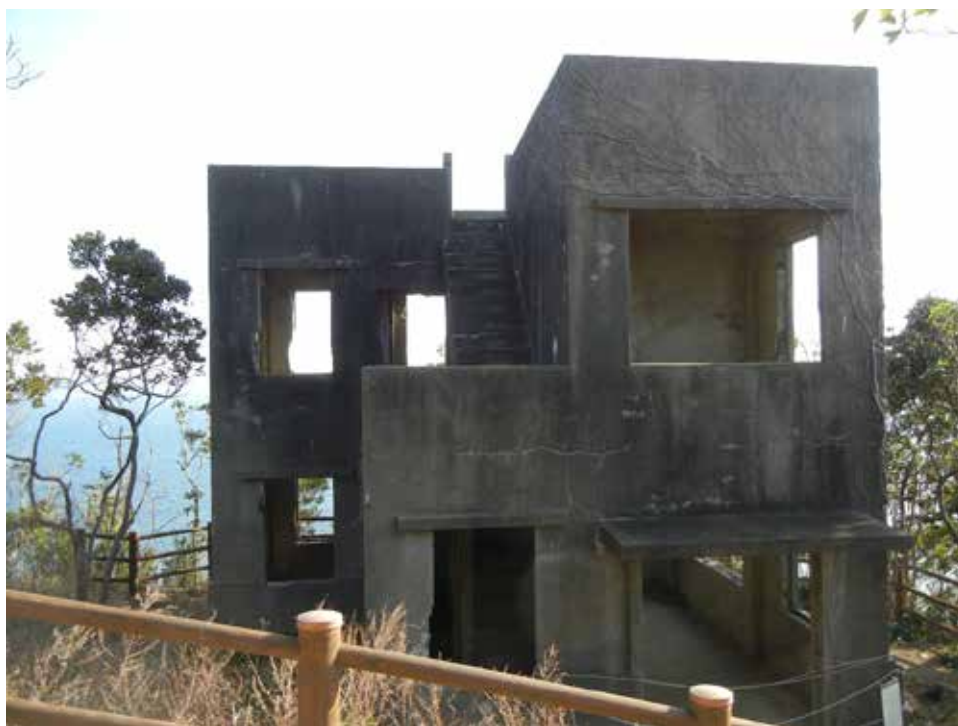
施工前の外観。
