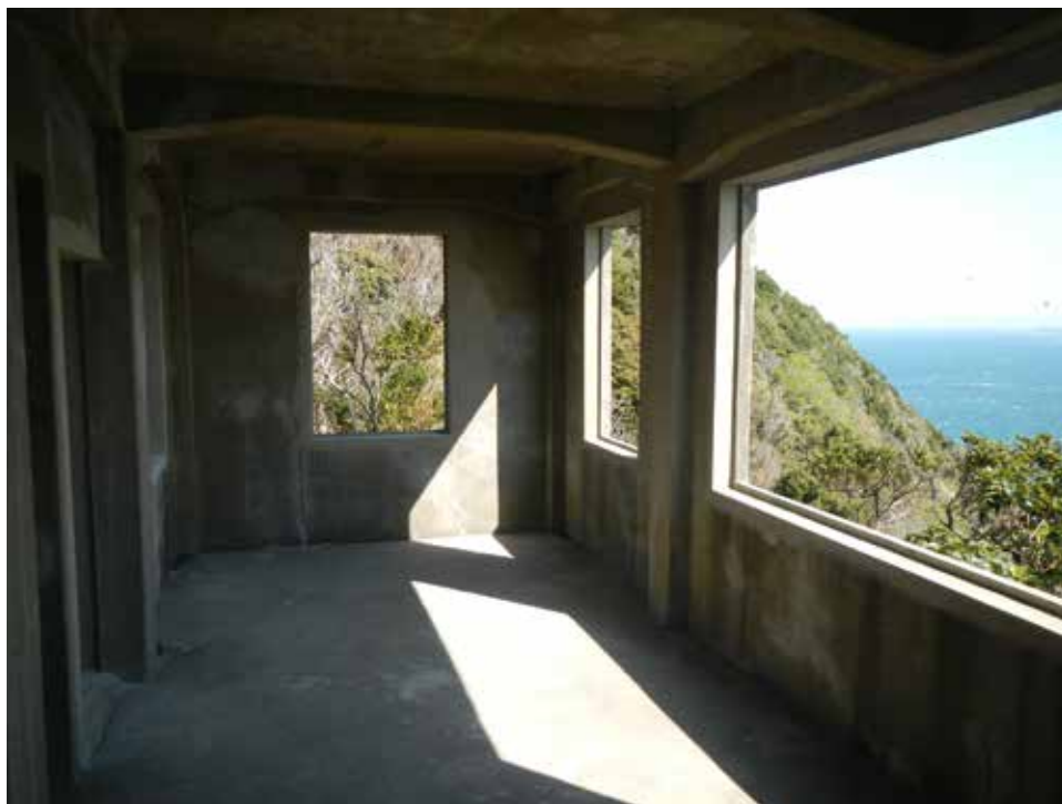
施工完了。2 階内部。
