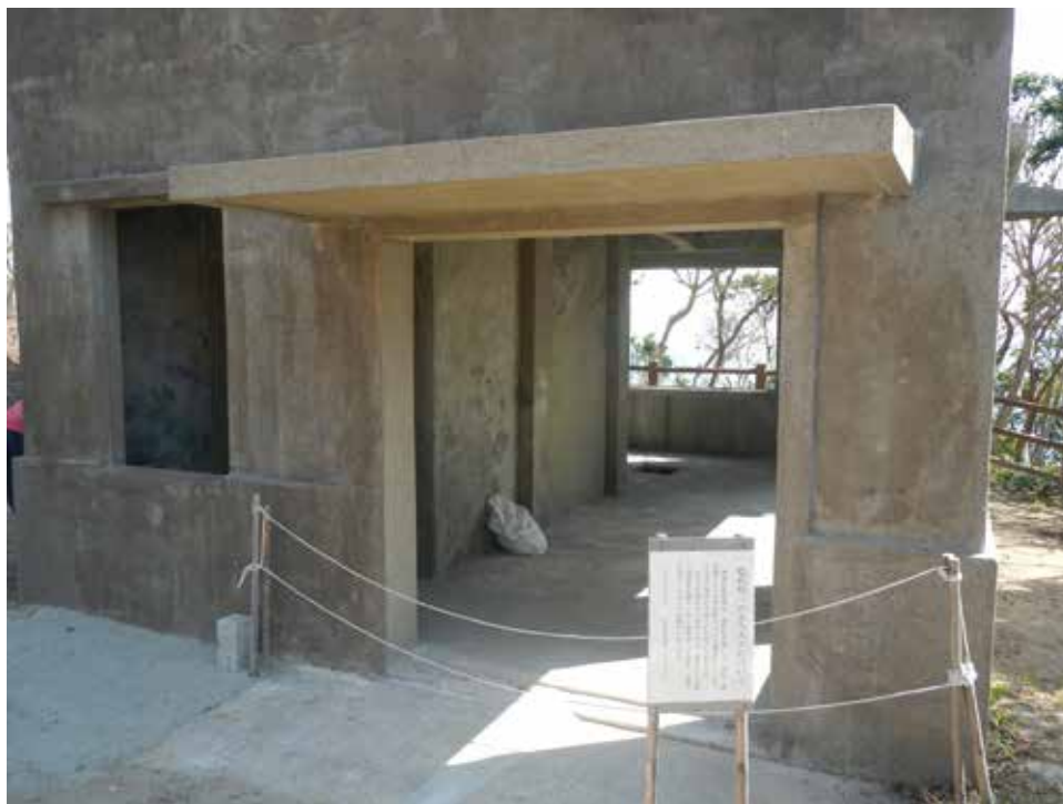
施工完了。外部西面。
