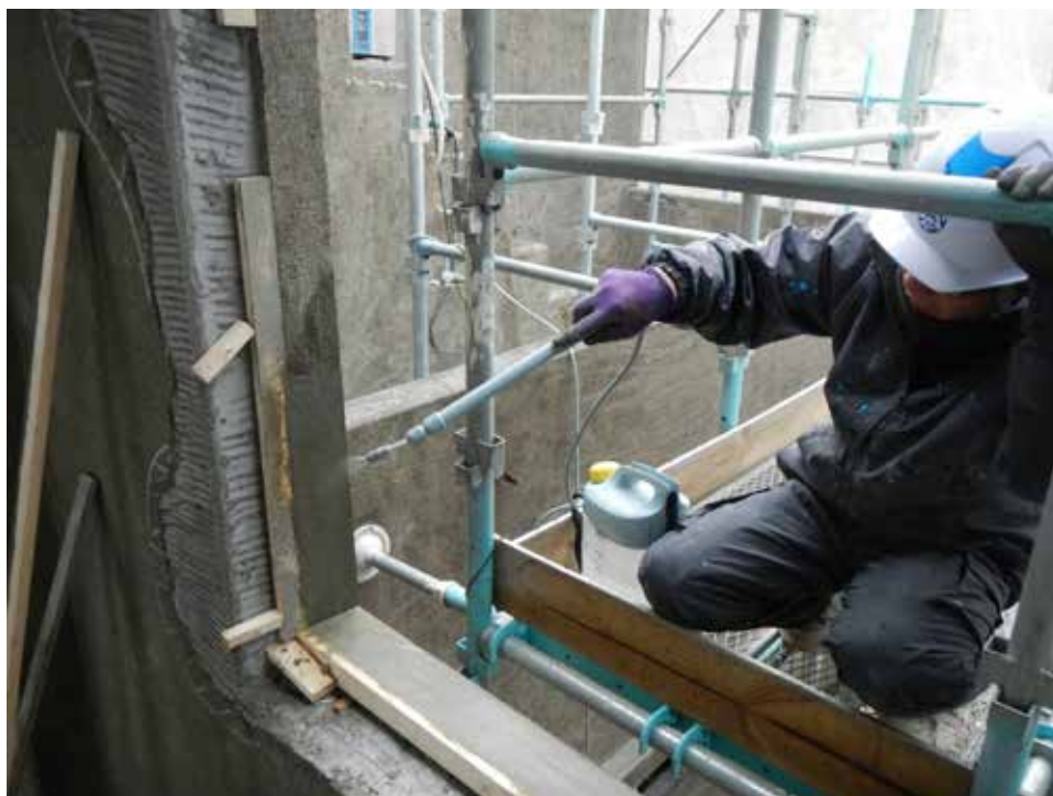
建具開口廻り表面仕上げ状況（洗出し）。
