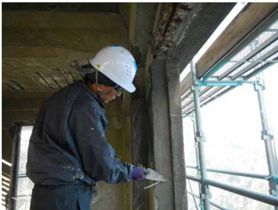
補修材（一材型靱性ファイバーモルタル）を塗布して、モルタル剥落、躯体欠損箇所の下塗り、粗付けします。
