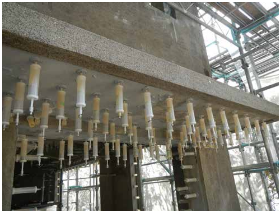
エポキシ樹脂注入状況。注入箇所は、ひび割れ箇所：6箇所 / m、剥離・剥落（断面修復）箇所：25箇所 / m 2 （写真は外部庇）。
