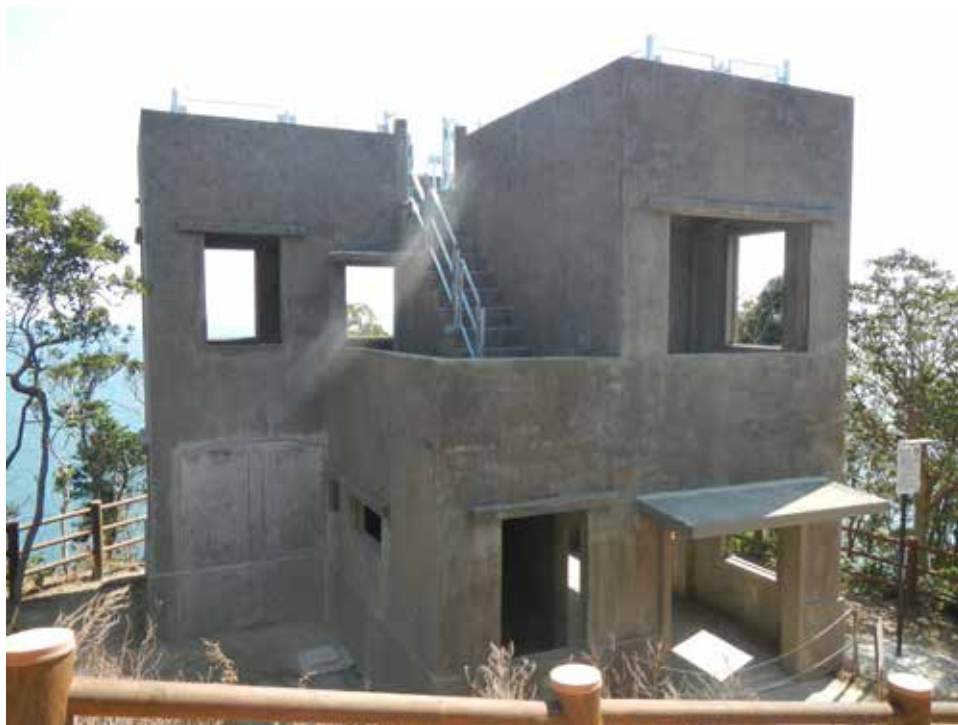
施工完了の外観（北西遊歩道より臨む）。
