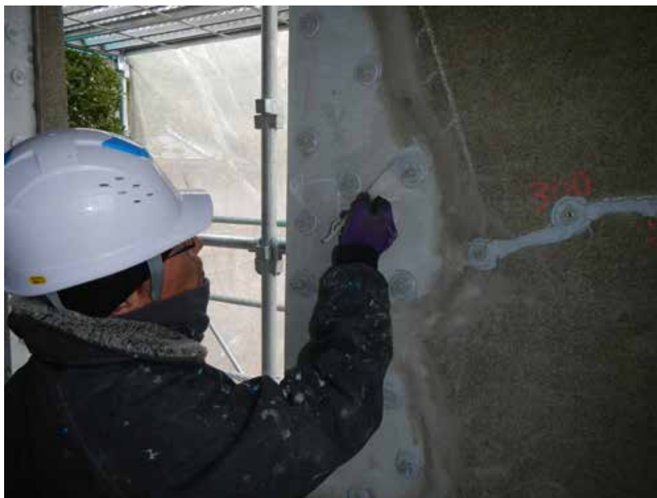
台座取付状況（写真は、内部剥落（断面修復）箇所）。
