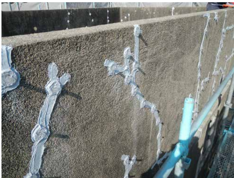
樹脂注入箇所に樹脂注入器具用の台座を取り付けます。また、ひび割れ箇所は樹脂漏れを防止するため、樹脂防漏材を塗布します（写真は、外壁ひび割れ箇所）。
