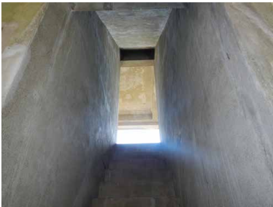
施工完了。内部階段。
