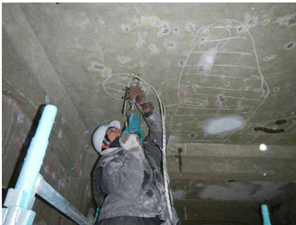
樹脂注入箇所の穿孔状況（内部天井ひび割れ、剥離・剥落（断面修復）箇所）。
