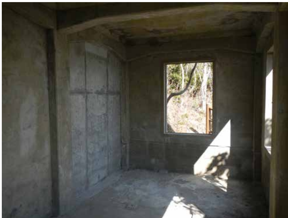
施工完了。1 階内部。写真奥左側の壁は、耐震補強のために設けられたコンクリート壁。
