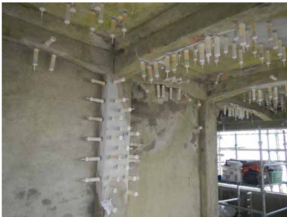
エポキシ樹脂注入状況。注入箇所は、ひび割れ箇所：6箇所 / m、剥離・剥落（断面修復）箇所：25箇所 / m 2 （写真は内部梁・柱）。
