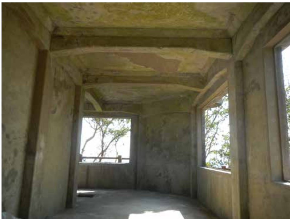
施工完了。1 階内部。
