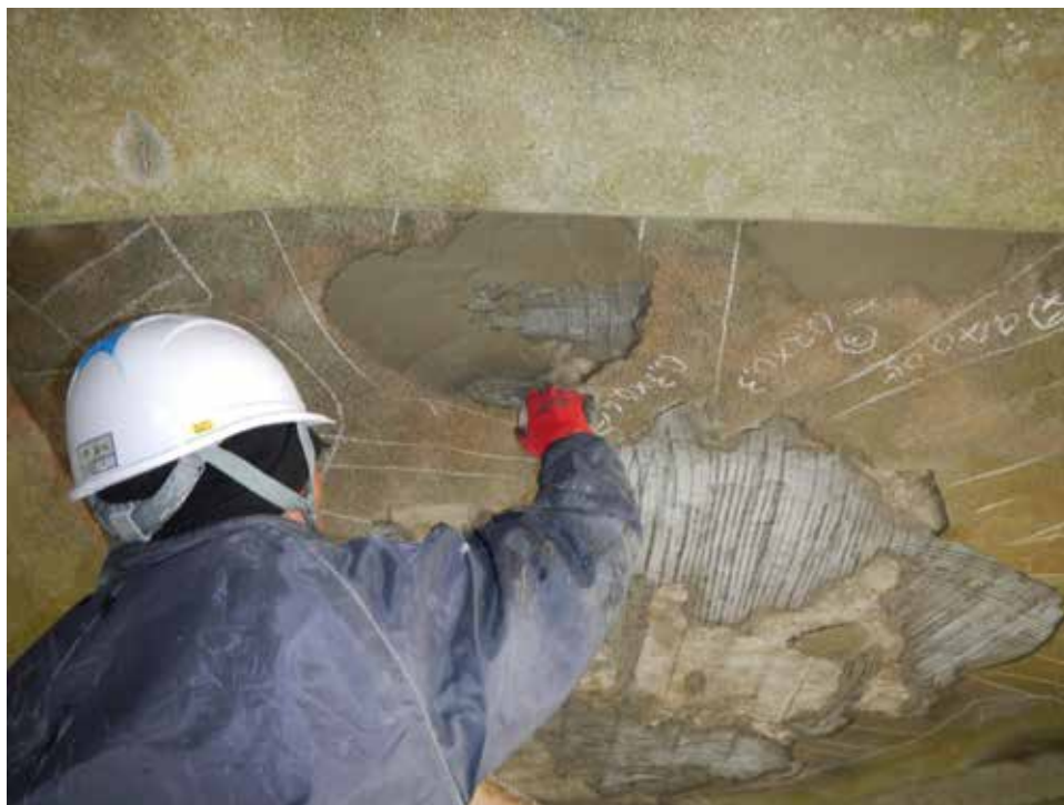
天井表面仕上げ状況（モルタル塗り）。
