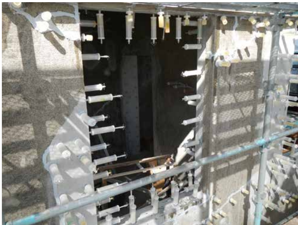
エポキシ樹脂注入状況。注入箇所は、ひび割れ箇所：6箇所 / m、剥離・剥落（断面修復）箇所：25箇所 / m 2 （写真は外壁・建具開口部廻り）。
