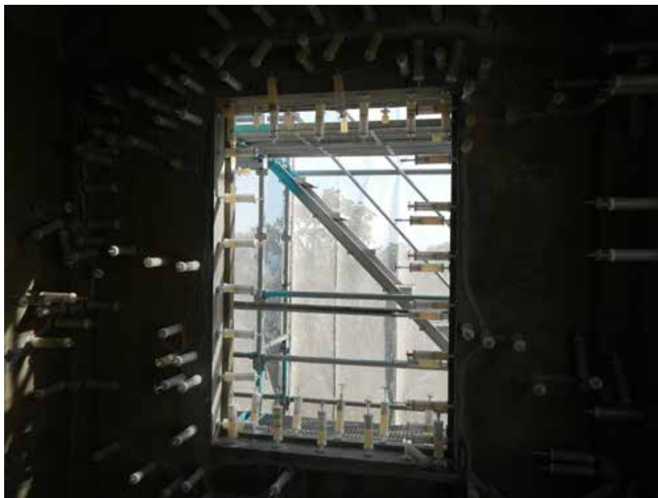
エポキシ樹脂注入状況。注入箇所は、ひび割れ箇所：6箇所 / m、剥離・剥落（断面修復）箇所：25箇所 / m 2 （写真は内部壁・建具開口廻り）。
