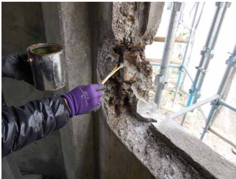
鉄筋露出箇所は、防錆剤（亜硝酸リチウム系）を塗布して発錆の進行を抑えます。
