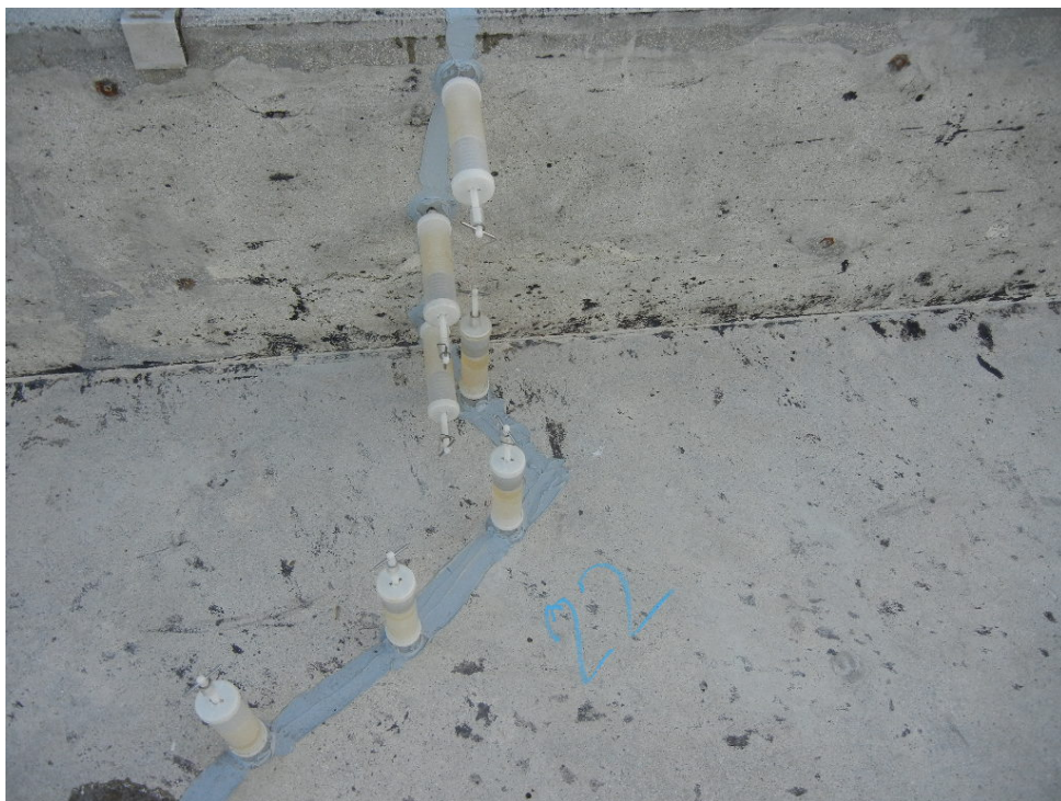
ひび割れ補修状況（パラペット立上り）
