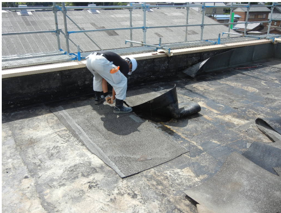
アスファルト防水 シート撤去
