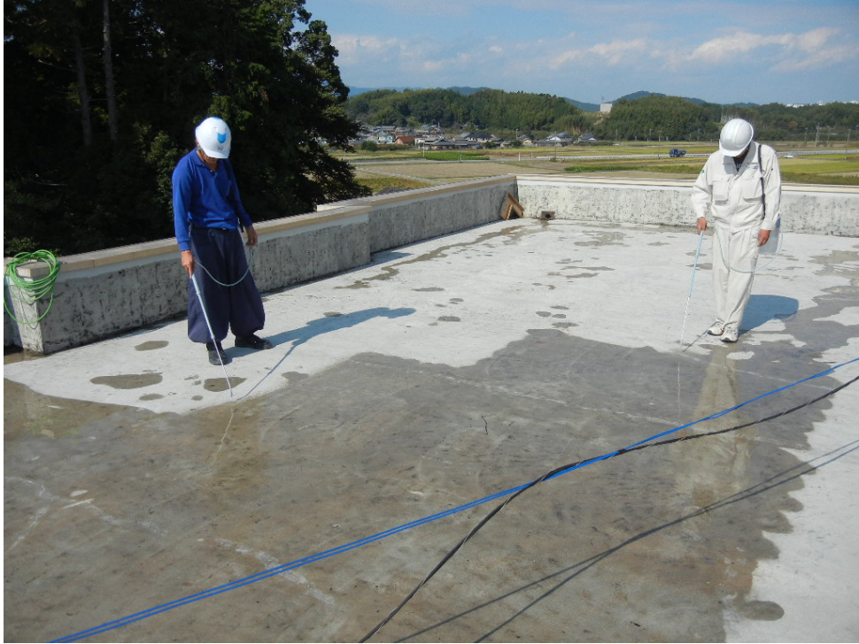
浸透性防水材塗布
