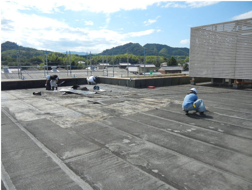
アスファルト防水 シート撤去
