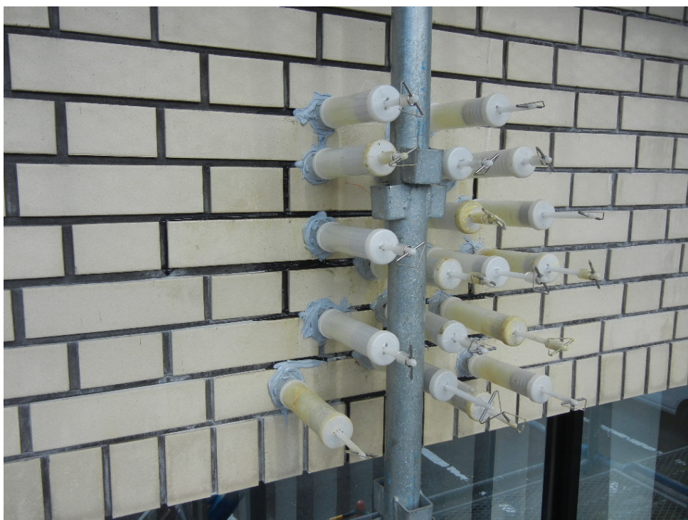
タイル浮き・剥離箇所のエポキシ樹脂注入（IPH システム工法）
