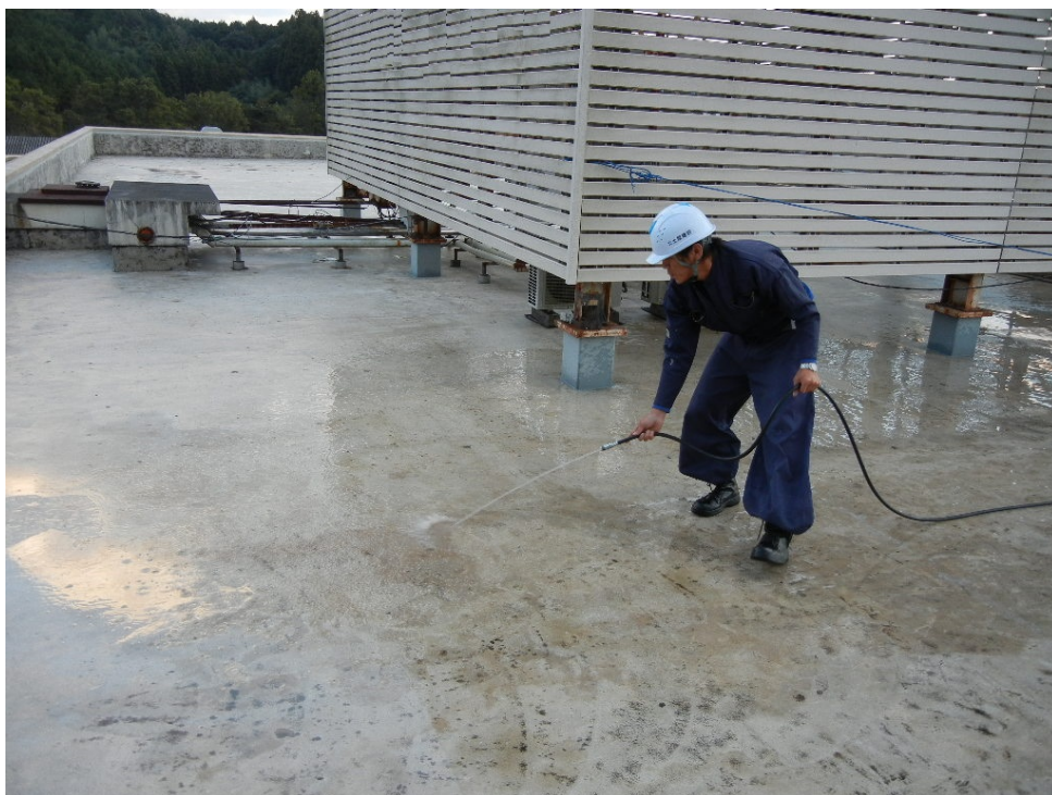
2次散水（余分な防水材の洗浄）
