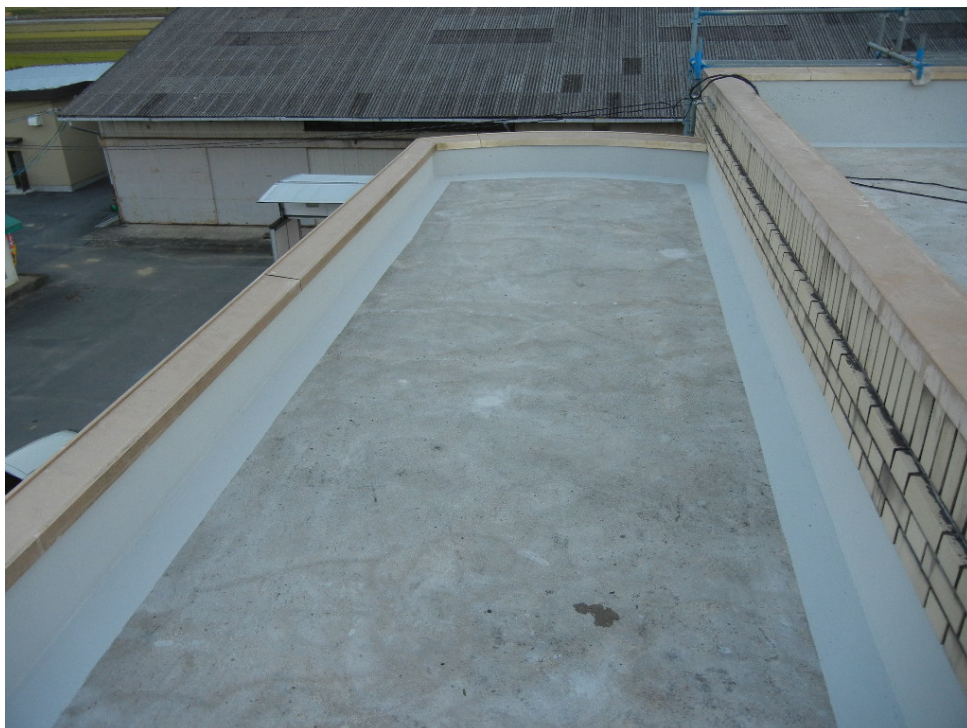
屋上スラブ（屋外階段屋根）
