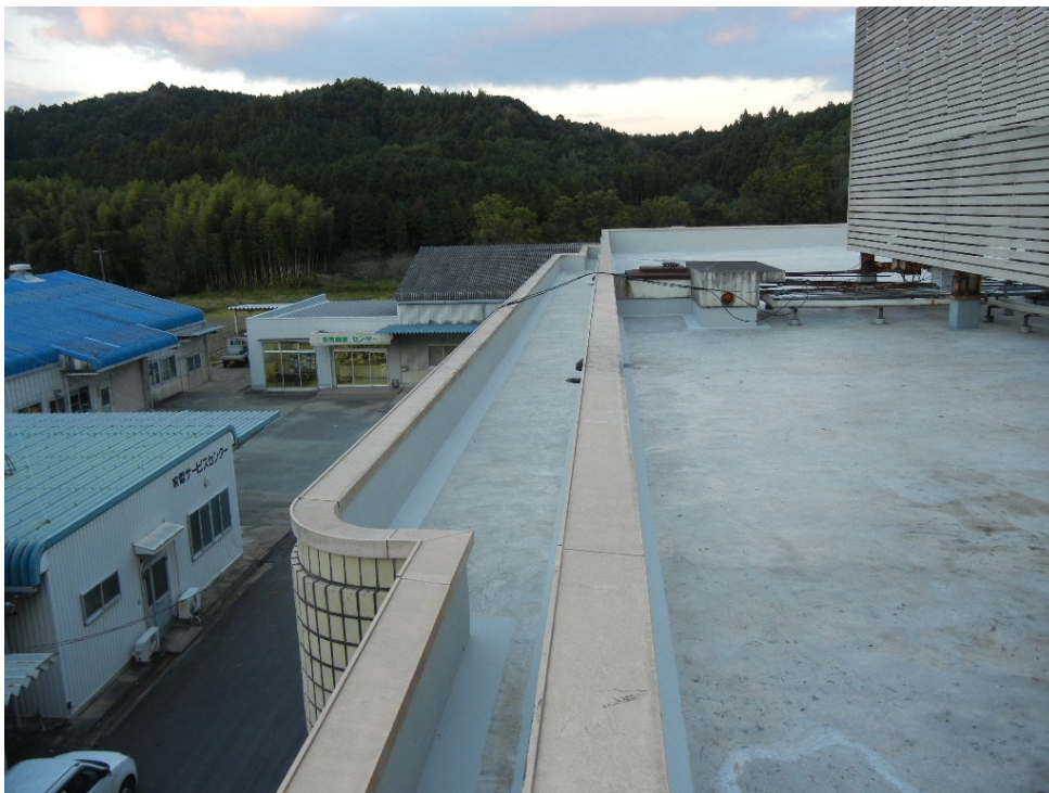
屋上スラブ（西側バルコニー庇）
