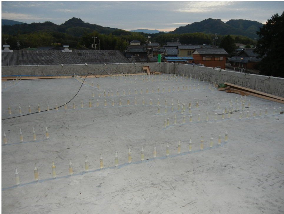
ひび割れ補修状況（平場）
