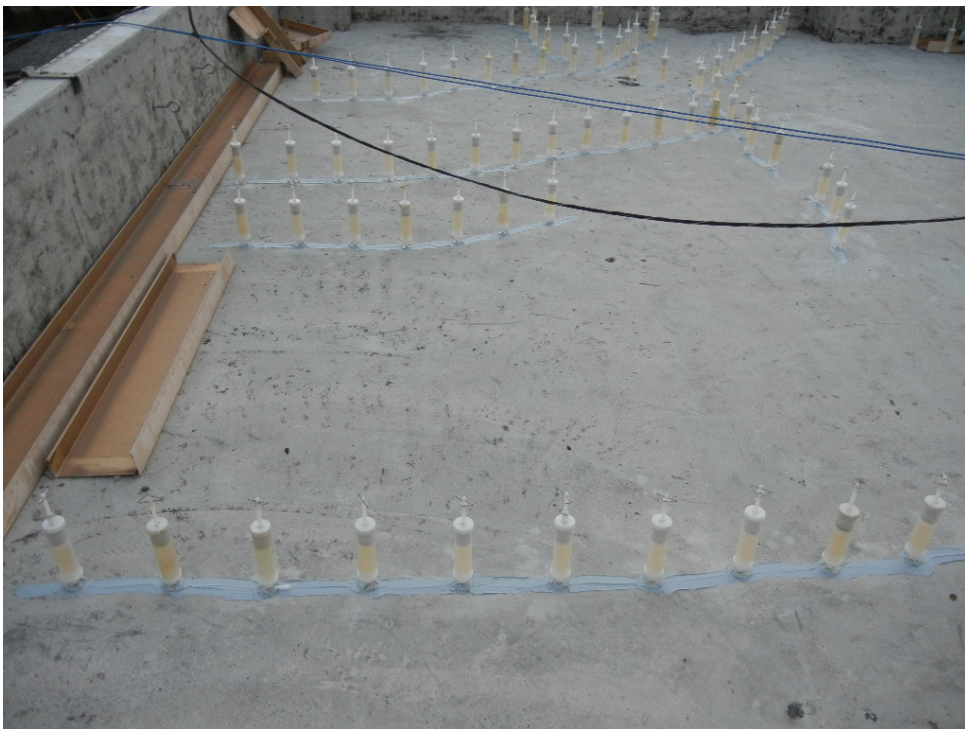
ひび割れ補修状況（平場）
