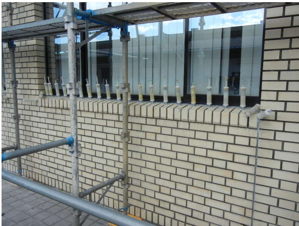
窓廻り漏水箇所及びタイル張付けモルタル未充填箇所のエポキシ樹脂注入（IPH システム工法）
