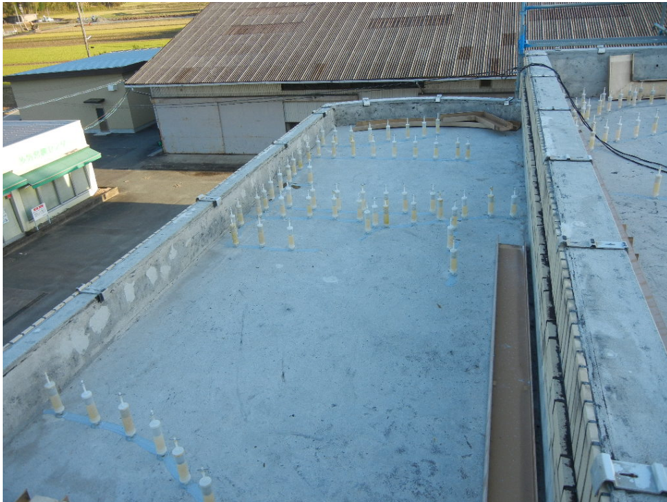
ひび割れ補修状況（屋外階段屋根）
