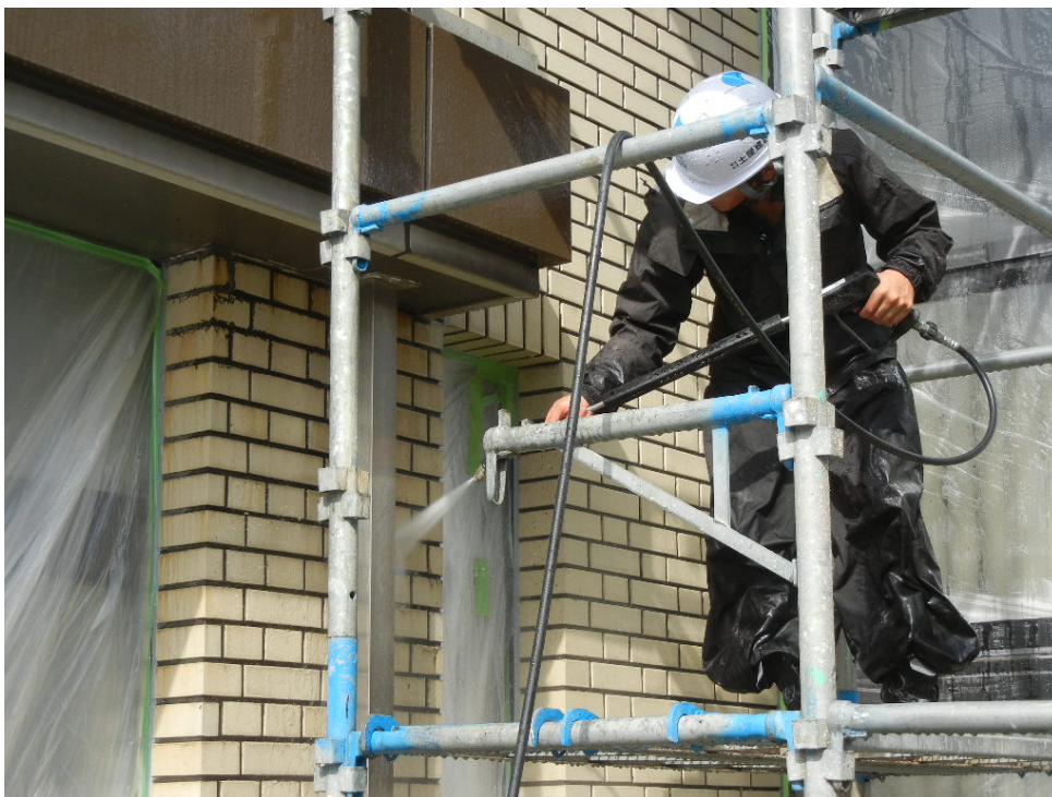
１次散水（防水材の浸透を促す）
