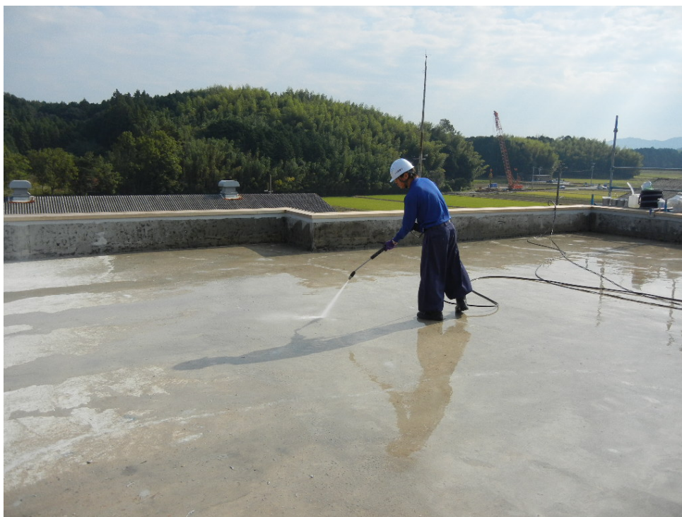
１次散水（防水材の浸透を促す）
