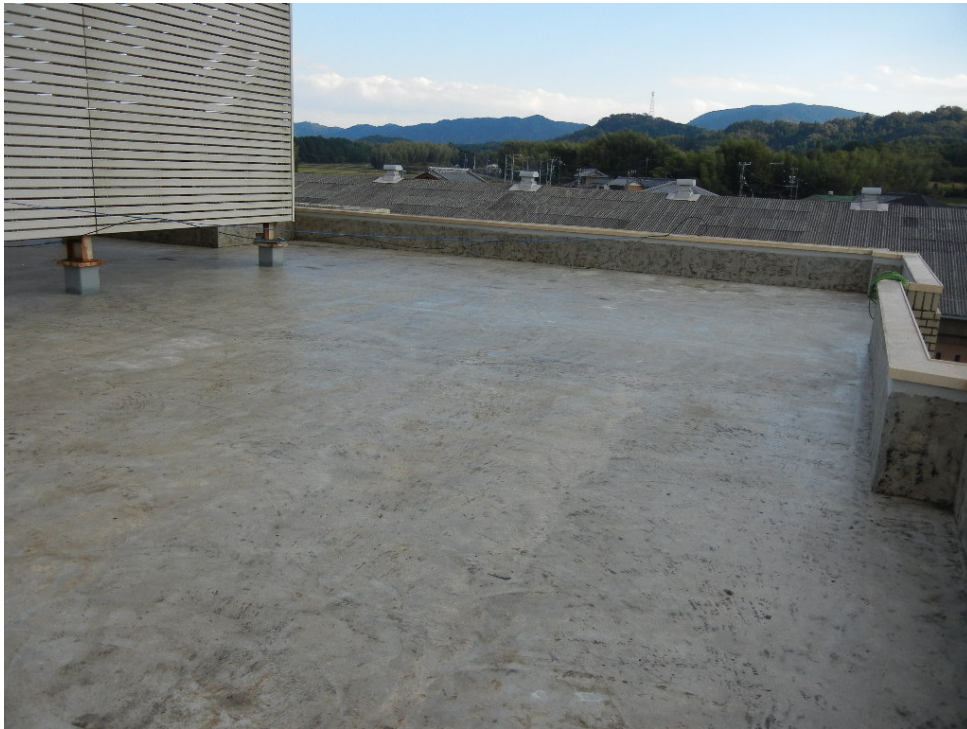
浸透性防水材塗布完了
