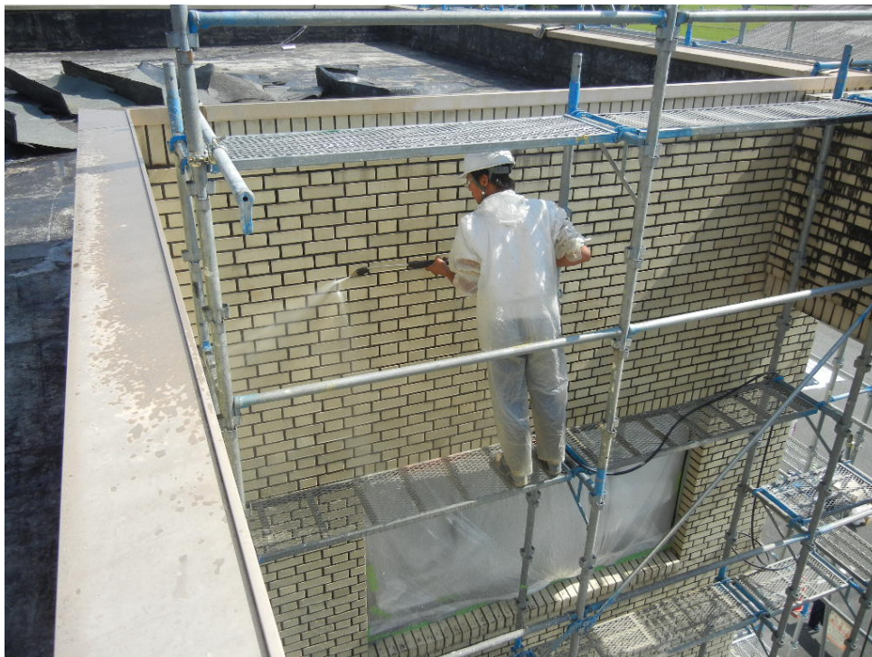
１次散水（防水材の浸透を促す）
