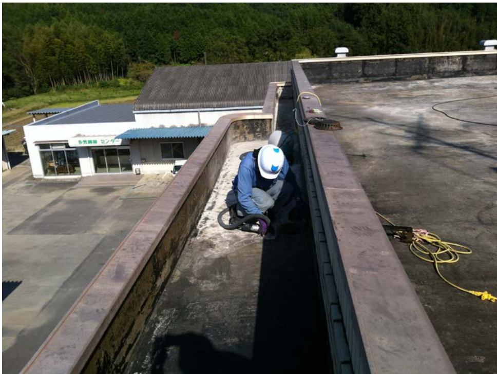
アスファルト防水 アスファルトの研削
