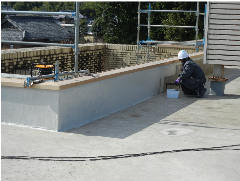
撥水型耐候性塗料塗布（パラペット立上り）
