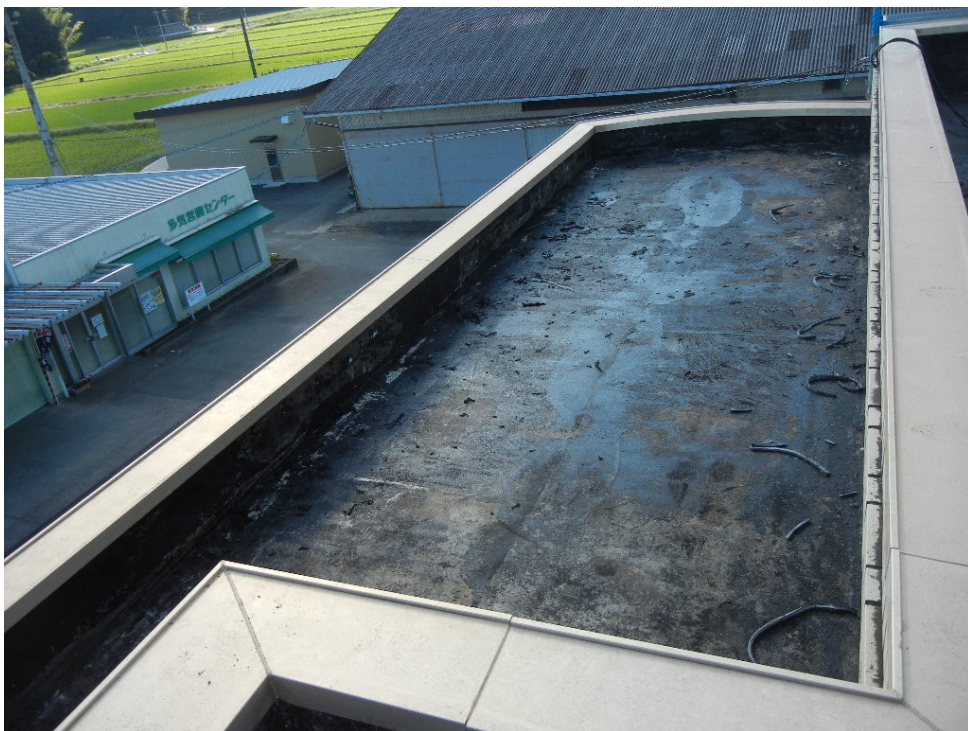
アスファルト防水 シート撤去
