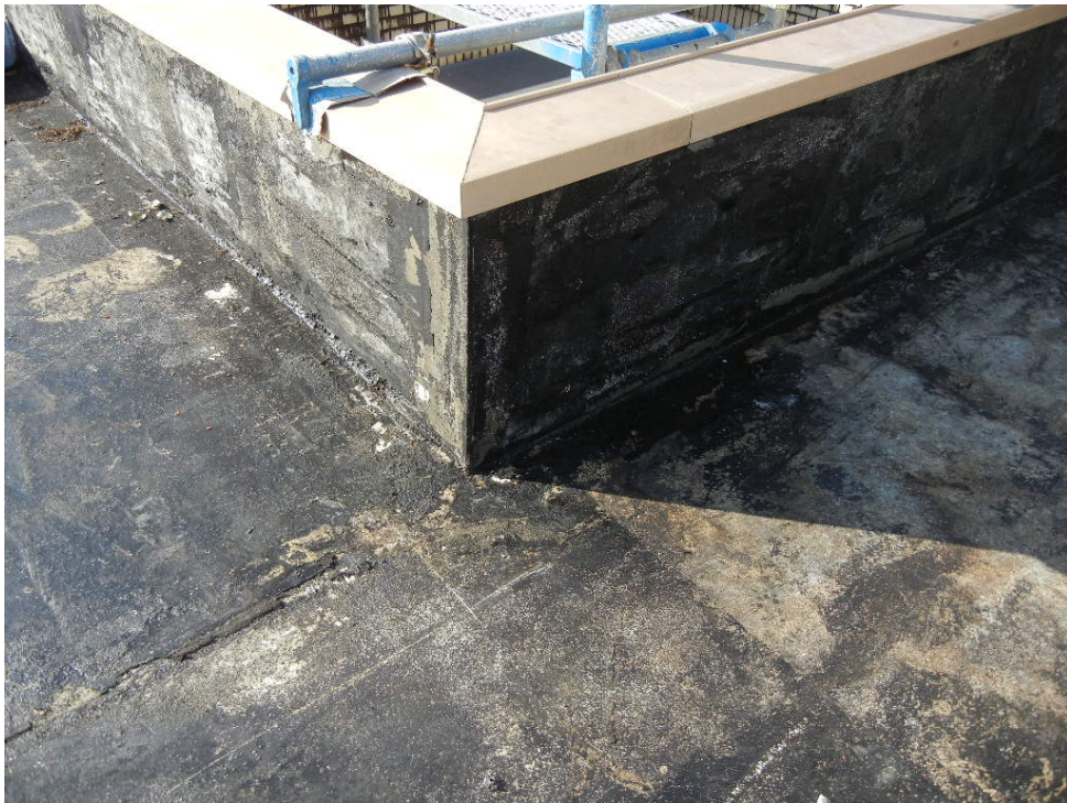
アスファルト防水 シート撤去
