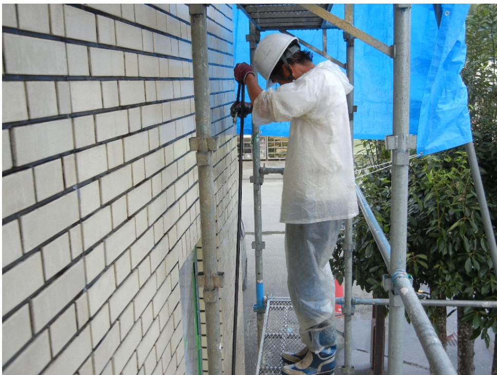
2次散水（余分な防水材の洗浄）
