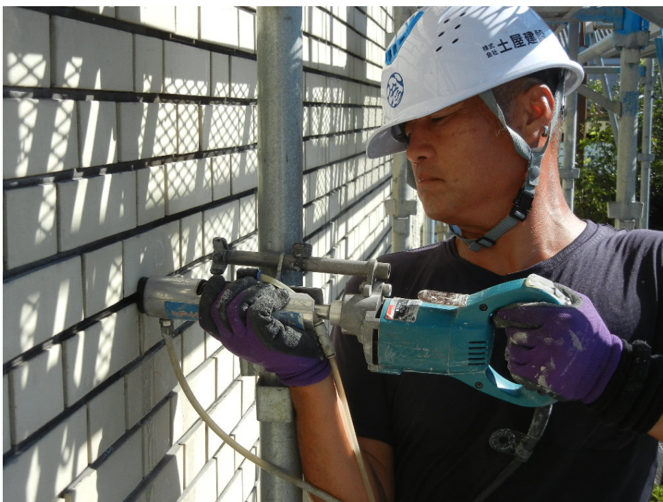
エポキシ樹脂注入箇所の穿孔作業（IPH システム工法）
