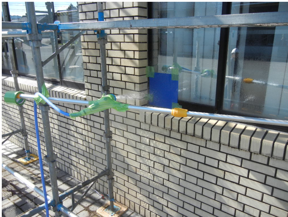
窓廻り窓台入隅への散水状況（1階 居室）
