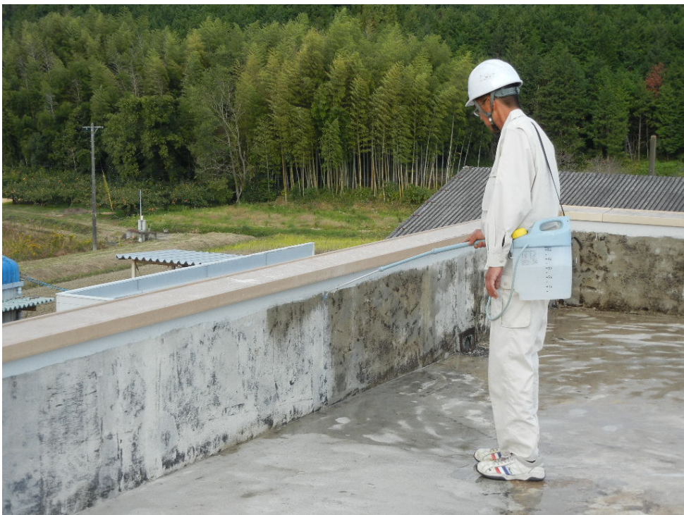
浸透性防水材塗布
