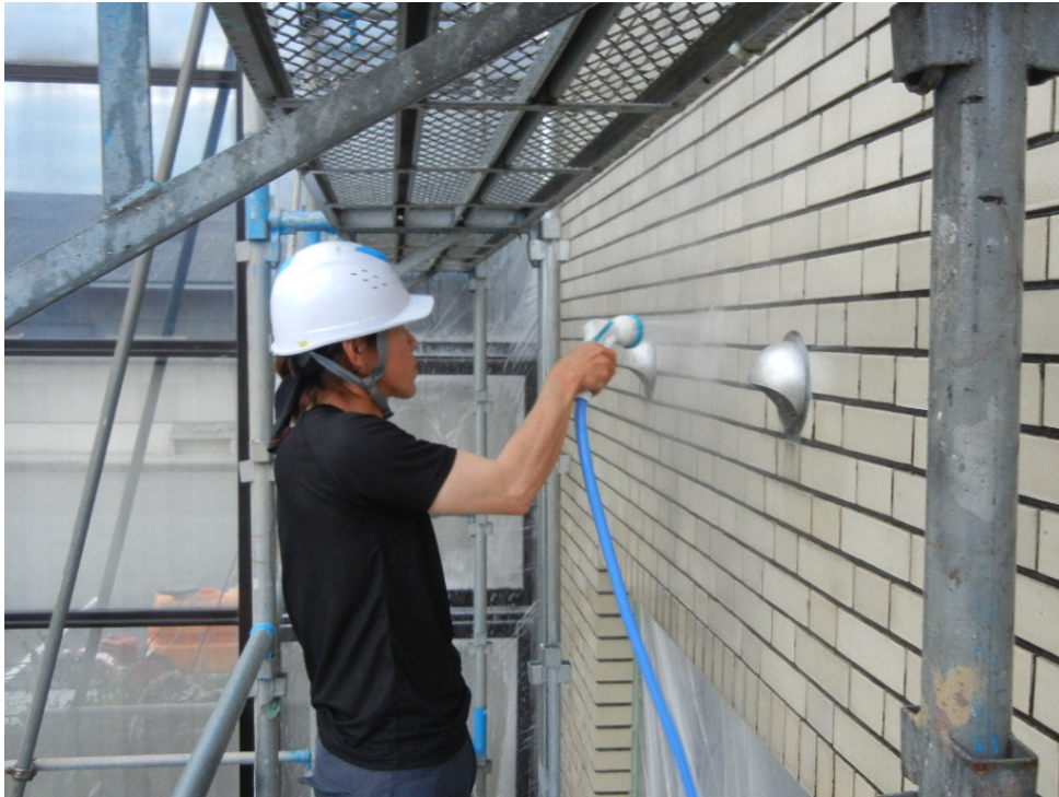
2次散水（余分な防水材の洗浄）
