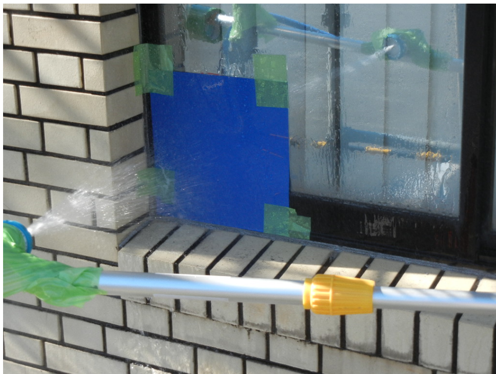
窓廻り窓台入隅への散水（塩ビシート(青)は、サッシ本体への水侵入を防いで散水の効果を目地、シールへ限定するために設置)
