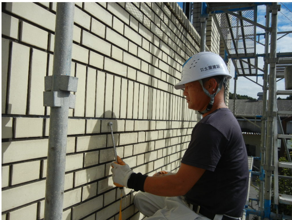
打診棒による打音検査（タイルの浮き・剥離箇所）
