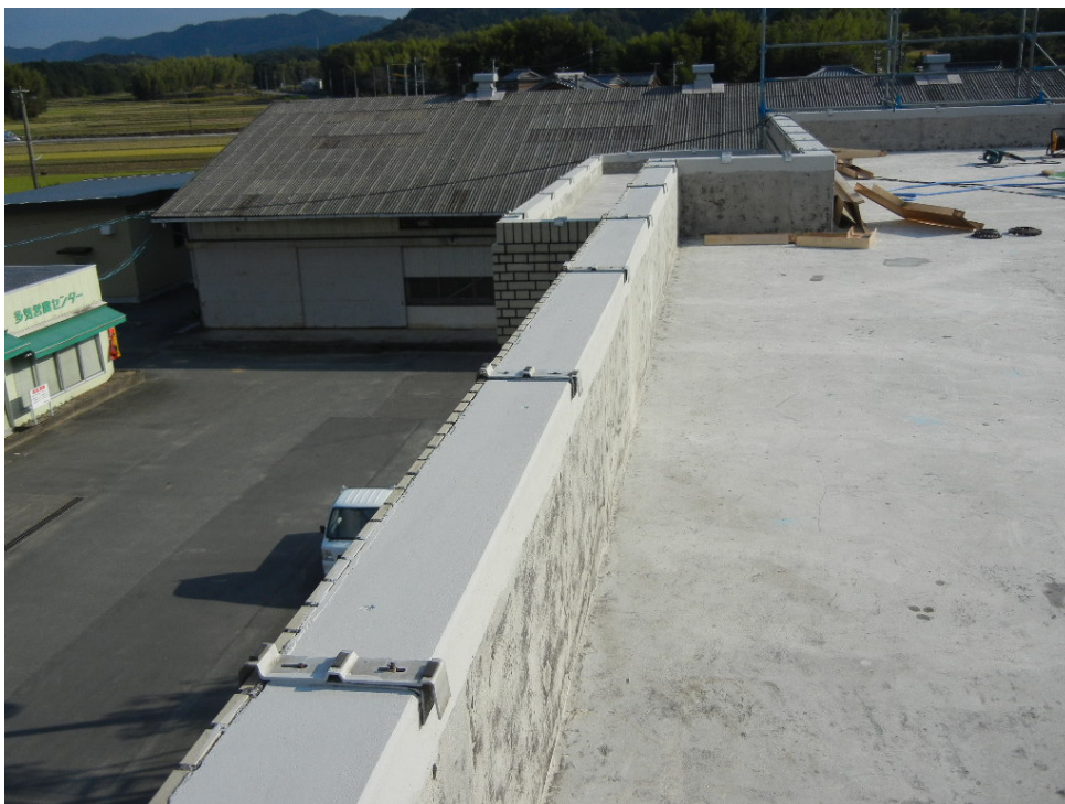
撥水型耐候性塗料塗布（パラペット天端）
