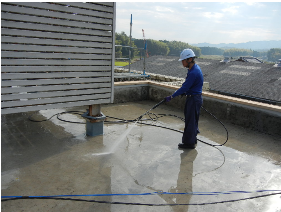
１次散水（防水材の浸透を促す）
