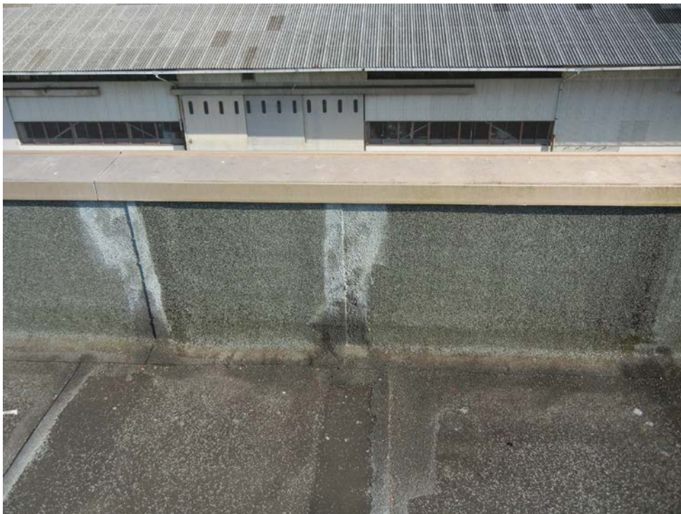
パラペットのシート継ぎ目
