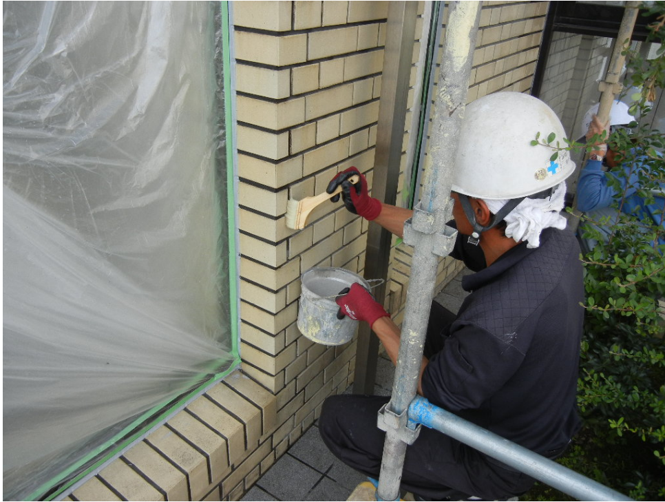
初期撥水型吸水防止材塗布（シッカリートWR）
